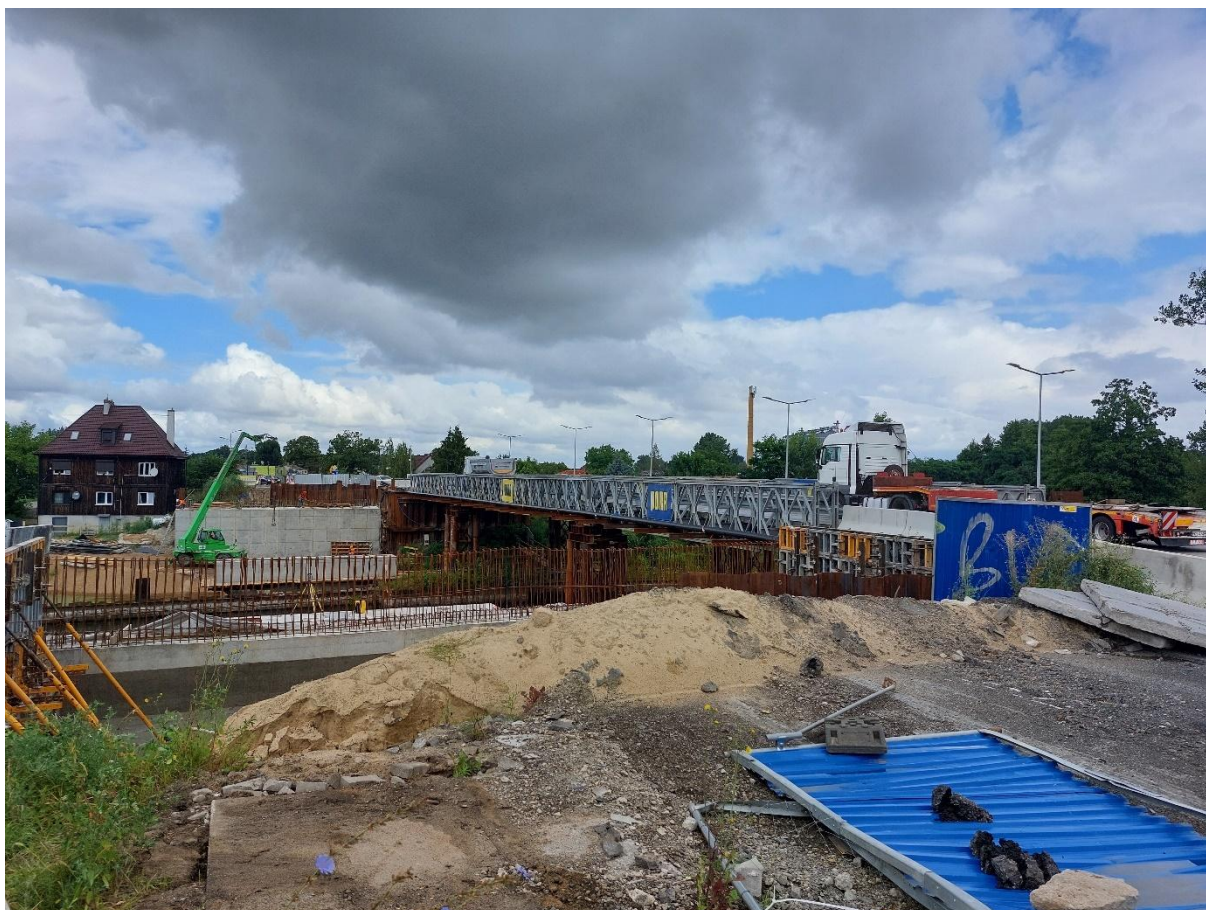
Ryc. 7: Remont przeprawy nad rzekami Noteć i Gwda w ciągu drogi nr 11 (05.08.2024 r.)
