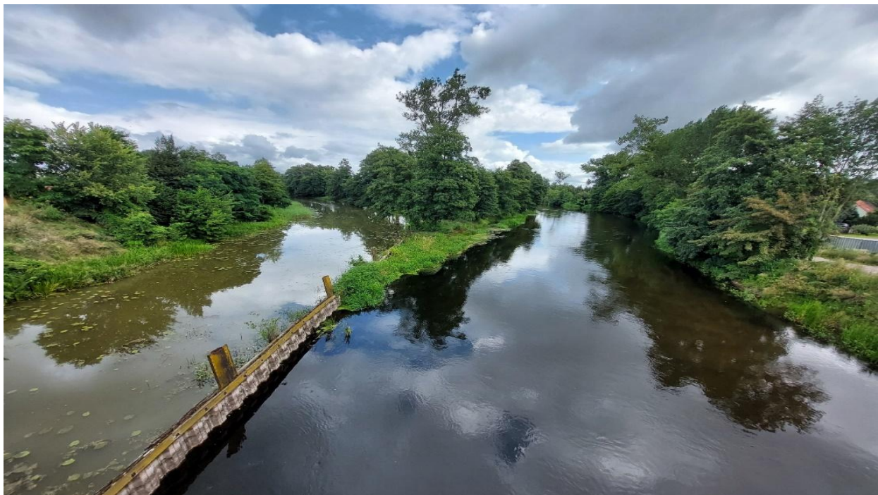
Ryc. 16: Rzeka Gwda i kanał do portu rzecznego w Ujściu Źródło: Wizja lokalna w dniu 5 sierpnia 2024 r.
